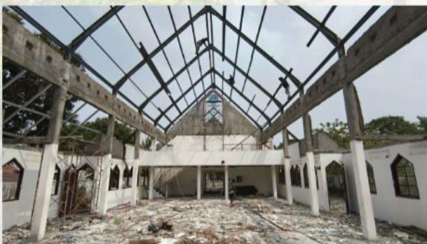
Erection dan Instalasi Rangka Atap Baja Gedung Utama
